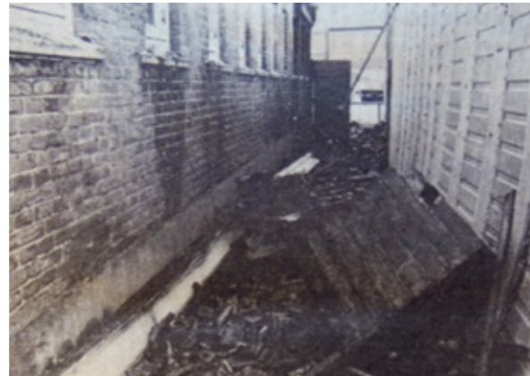
Afb. 9. Sloop van de 1e OLS en de onderwijzerswoning; Bron: De Zwijndrechtsche Combinatie 2 februari en 23 februari 1977.
