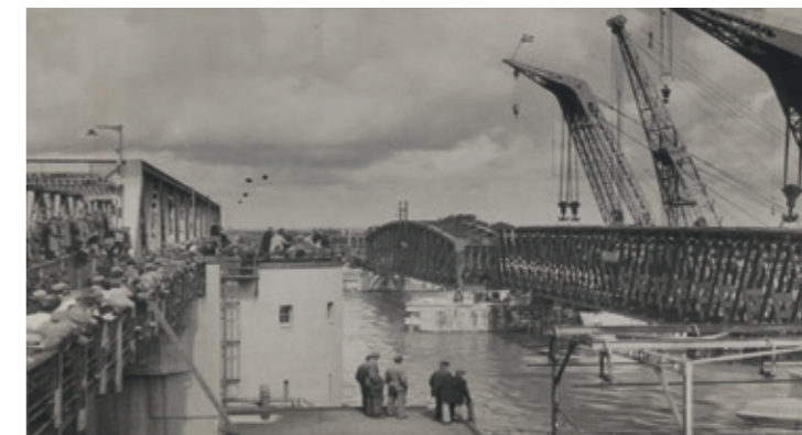
Het terugplaatsen van een (eensporig) brugdeel trok veel bekijks. Duizenden mensen konden deze gebeurtenis vanaf de hoger gelegen verkeersbrug prima zien. RAD, Gemeentelijke prentenverzameling, inv.nr. 552_321499.
