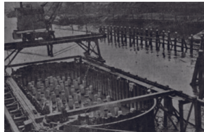
Een close-up van een van de fundamenten aan de Zwijndrechtse kant. Zie ook de Dordrechtsche Courant van 25-05-1936, p. 14.
