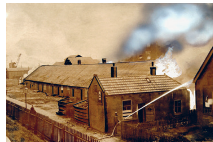
De huizen in de Guanostraten worden gecontroleerd uitgebrand, omdat zij plaats moeten maken voor de verkeersbrug over de Oude Maas.
