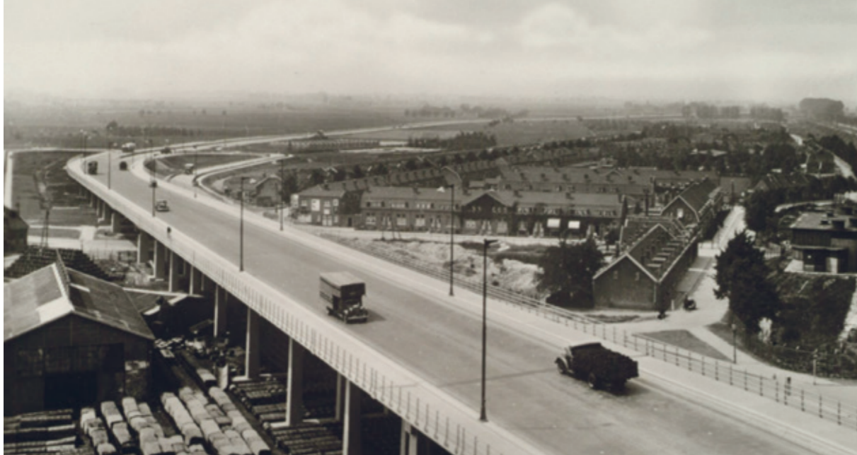
De viaducten aan de Zwijndrechtse kant in de jaren vijftig. Goed te zien is dat de viaducten verschillende terreinen moesten overbruggen. Op de achtergrond staan de op- en afrit ten westen van de Da Costastraat. Collectie auteur.
