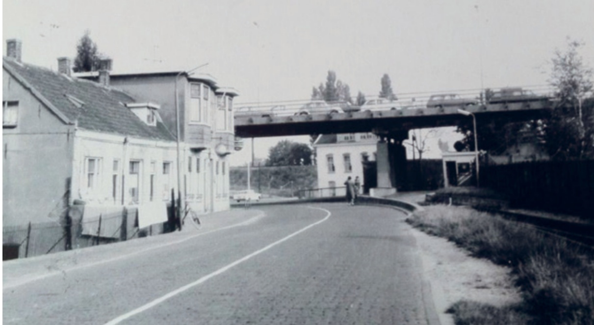
Blik vanaf de Lindtsedijk op het viaduct naar de verkeersbrug in de jaren zestig. Links was het café Van Schelt. Daarachter is rechts onder de brug de tabakskiosk van Jaap Bot te zien en daarnaast de patatkraam van Den Boef. Aan weerszijden liggen de trappen naar de verkeersbrug. Helemaal achteraan zien we de contouren van 'het witte huis'. Op de verkeersbrug de dagelijkse file. Collectie HVZ.
