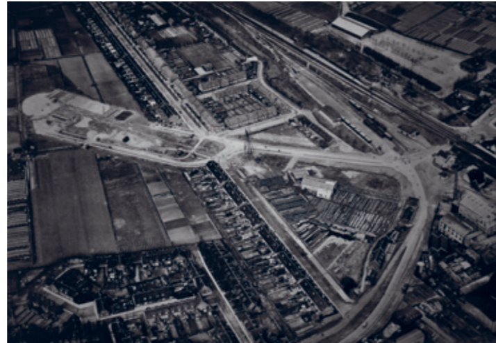
Een luchtfoto van de aanleg van de viaducten van de verkeersbrug over de Oude Maas. Onder meer moesten voor dit omvangrijke project tientallen huizen in de Da Costastraat gesloopt worden. Bovendien werd de straat door het viaduct doormidden gesneden. Foto uit: K. van der Leer, K. Popijus, Zwijndrecht van boven bekeken. 1923-1991. (Hoogeveen 2005).
