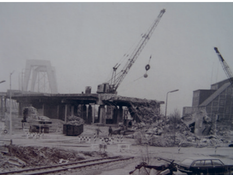
De viaducten naar de verkeersbrug worden gesloopt. Collectie HVZ.
