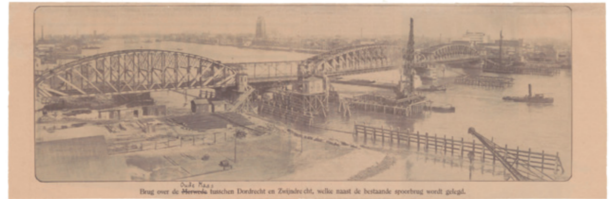
De fundamenten van de pijlers worden gelegd naast de pijlers van de spoorbrug. Binnen de damwanden worden de palen eerst geheid en vervolgens geschroefd. RAD, Gemeentelijke prentenverzameling, inv.nr. 552_131339.
