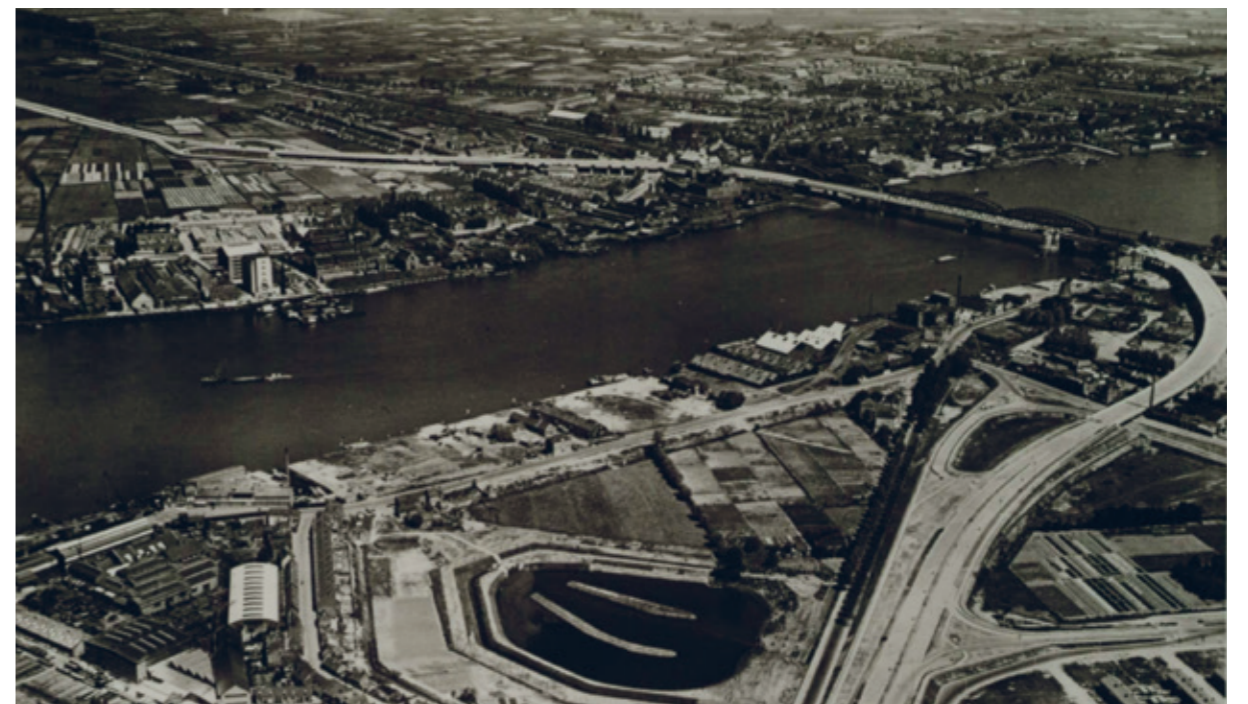
Een luchtfoto van Rijksweg 16 ongeveer een jaar na de opening. Duidelijk te zien is dat het een enorme opgave was om deze verkeersweg te bouwen. Niet alleen de brug zelf was een hele onderneming geweest, ook de bochtige viaducten waren al hele klussen op zich. RAD, Gemeentelijke prentenverzameling, inv.nr. 552_330544.
