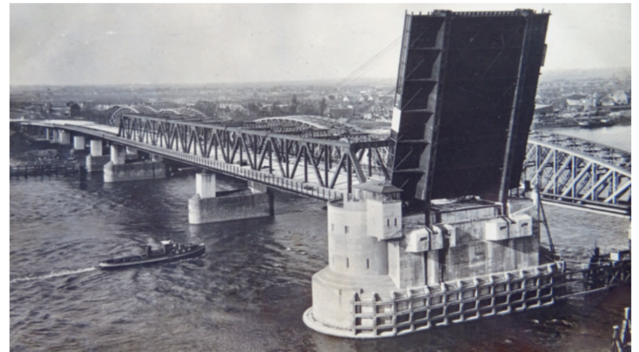
De verkeersbrug net na de opening in 1939 in haar volle glorie, met openstaande kleppen. Collectie auteur.
