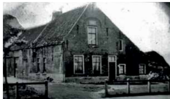
Bij de boerderij aan de Lindelaan is duidelijk te zien dat de rechterzijbeuk is uitgebouwd. De melkkelder, waarvan de ramen net boven het maaiveld geplaatst zijn, zit onder de opkamer, waar men de melk verwerkte. Deze boerderij stamde deels uit de zestiende eeuw. Collectie Vergulde Swaen.
