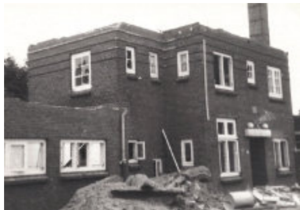
Sloop van het gebouw in 1976. Collectie Bastiaan Los.
