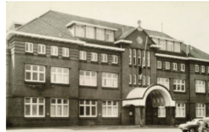
Het Rooms-katholieke ziekenhuis aan de Houttuinen in Dordrecht eind jaren vijftig. Collectie RAD.
