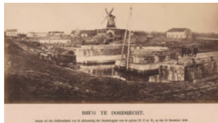
Bouw van de spoorbrug over de Oude Maas in de periode rond 1866. Op de achtergrond de molen de Rietvink, die generaties lang in het bezit was van de familie Broeksmit. Collectie RAD.
